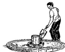
Vierta el concreto para la losa y forme el collar protector.
