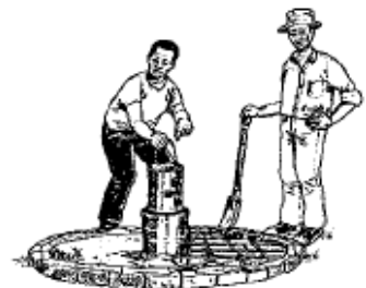
برای سوراخ، سیم های تقویتی در قالب را جایجا کنید
