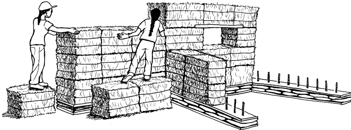
مواد ساختمانی سبک، مانند بسته های گاه، دیوار ها ایرا میسازند که در هنگام زلزله کمتر خطر دارند. در ضمن حرارت داخل اطاق را ملایم نگه میدارند.
