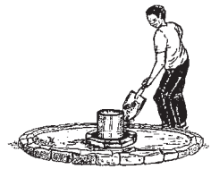
Beton örtügiňiň şekilini garylan beton bilen dolduryň.
