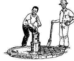
Kuvvetlendirici telleri yerleştirin, delik için kalıp yapın.
