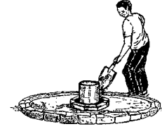
Betonu kapak oluşturacak biçimde dökün, koruyucu halkayı oluşturun.
