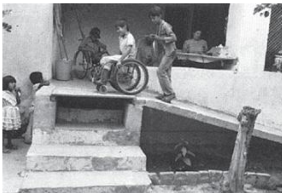
Дөңгөлөктүү отургуч менен жүргөндөр айылынын эмканасына оңоюраак кирип-чыга алуусу үчүн, Piaxtla долбоорунун медициналык-санитардык кызматчылары бул пандусту куруп беришкен.
