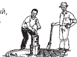
Худгийн тагны голд нүх гаргаад бэхжүүлэгч арматур байрлуулж байгаа нь.
