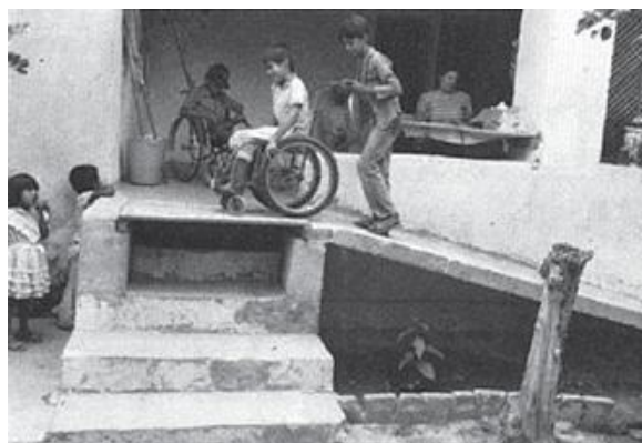
Медико-санитарные работники проекта Пиакстла соорудили этот пандус, чтобы люди в креслах-колясках могли без особых усилий попасть в поликлинику. (Фото Джона Фаго)
